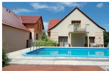
Původní penzion s novou přístavbou a venkovním bazénem.
